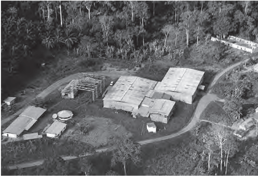
Fabrikanlage des Brunnen- projektes mit Auto-Garage, Lager und Produktions- stätte der Brunnen- elemente.
